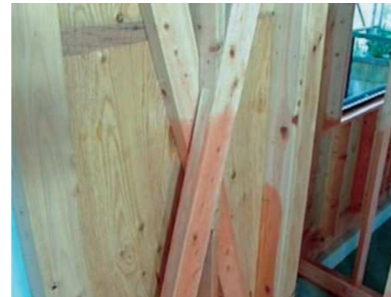
ダブル筋交い部の施工例
