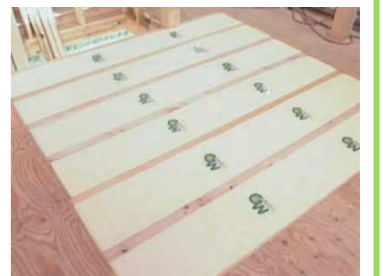
外気に接する床の施工例
