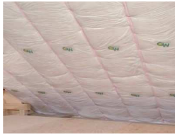
屋根の施工例
