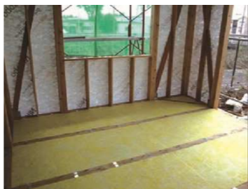
剛床(根太レス)の施工例
