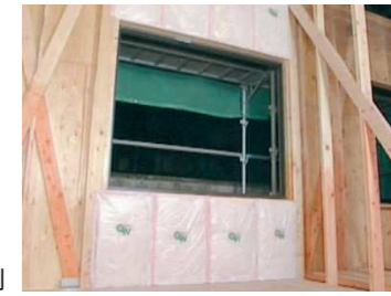
開口部周りの施工例
