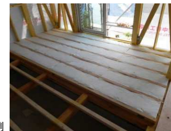
根太床の施工例
