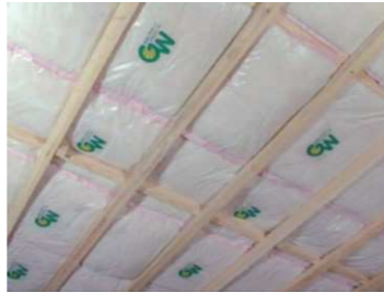
天井の施工例
