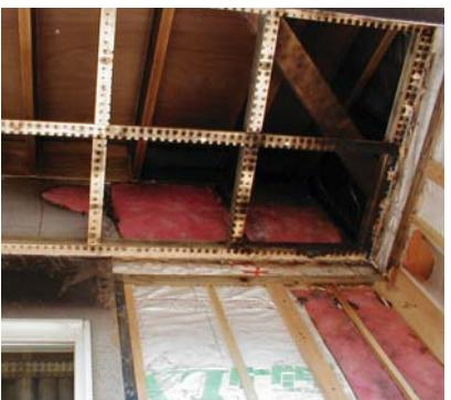
【火災時の写真】天井部分は燃えても、天井や壁の中のグラスウール断熱材(ピンク)は、燃えたり、変形していません。
