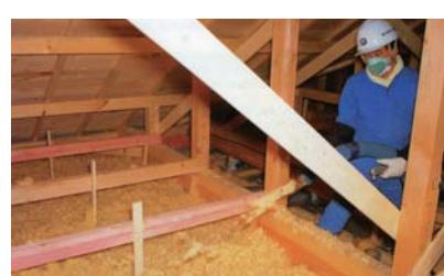
吹き込み式天井断熱施工
