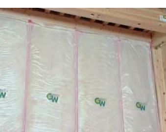
フェルトタイプ(袋入り)を使用した壁の断熱施工
