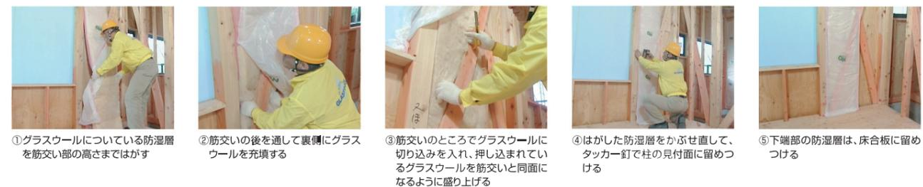
**施工のポイント** ①グラスウールを筋交いの裏側にも充填し、筋交いに沿って切り込みを入れ同面まで盛り上げる。②防湿層を筋交いに留めつけて断熱層と防湿層の連続性を確保する。
