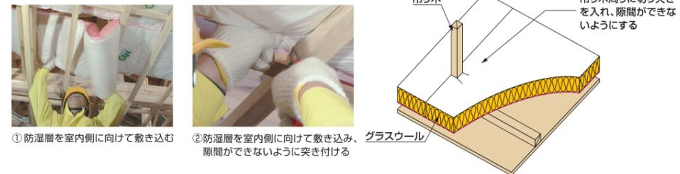
**施工のポイント** ①吊り木や間仕切壁周りに隙間ができないように注意する。②押入やクローゼットの上部の入れ忘れに注意する。
