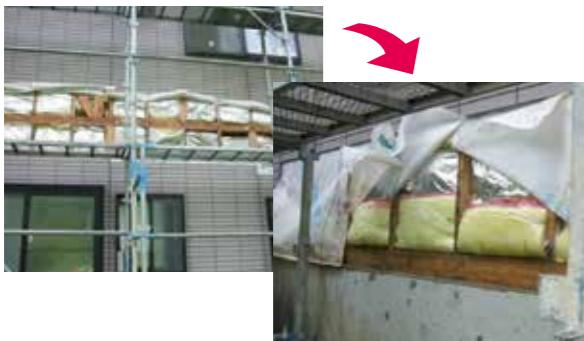
既存の外壁材を部分的に撤去して、土台上・胴差上下・軒下部分に**気流止め**(※)を施工しました。
