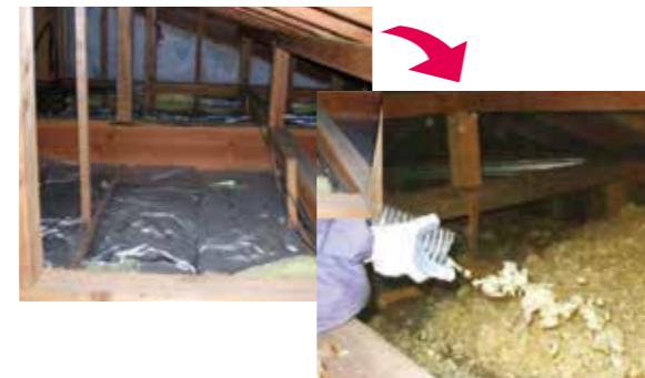
天井裏に、既存のグラスウール10K100mmに加えて、吹込みグラスウール300mmを施工しました。夏場の暑さ対策もこれでOK。
