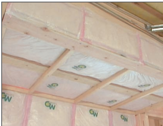
下屋の施工例（天井断熱の場合）
