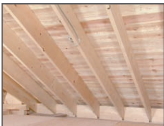
①施工前の状態。
