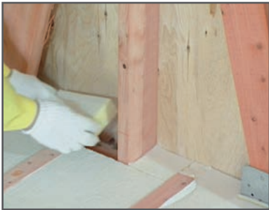
①外側まで床用グラスウールボードをすき間なく施工します。
