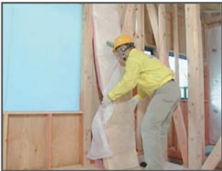
① グラスウールについている防湿フィルムを床から筋交い部の高さまではがします。
