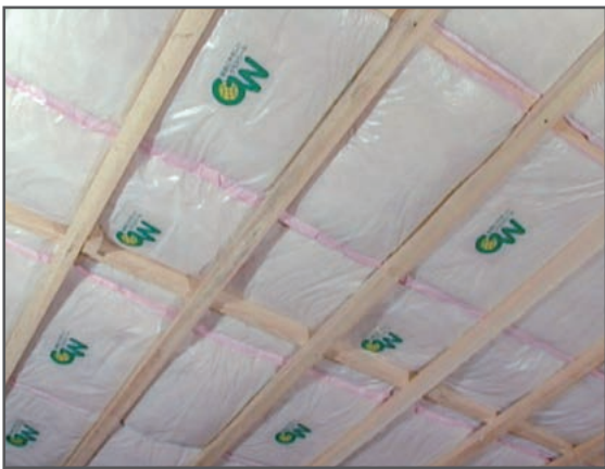
天井の施工例
