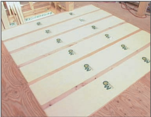
外気に接する床の施工例
