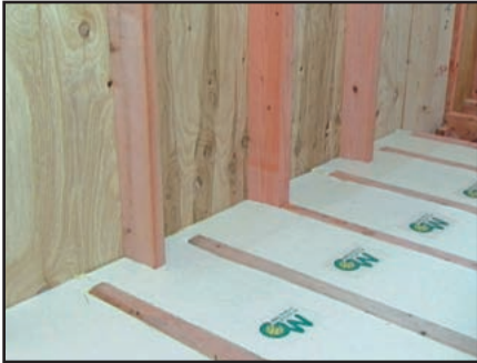
和室の床の施工例
