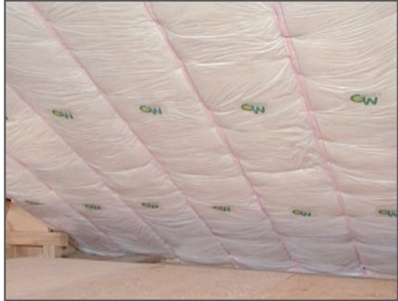
屋根の施工例
