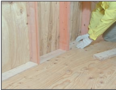
②気流止めとして乾燥木材を間柱の間に納まるようにカットして施工します。
