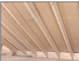
②通気層確保部材を施工する。
