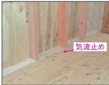
③気流止めの乾燥木材を留めつけます。
