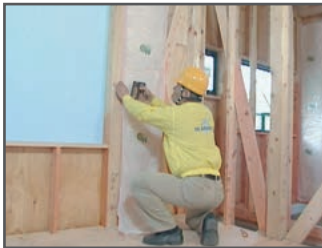
④ はがした防湿フィルムをかぶせ直して、タッカー釘で間柱の見附面に留めつけます。
