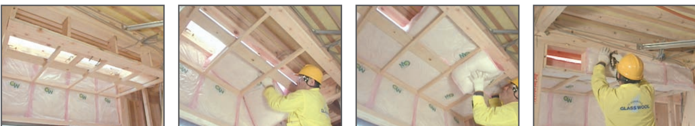
下屋の施工例（天井断熱の場合）
