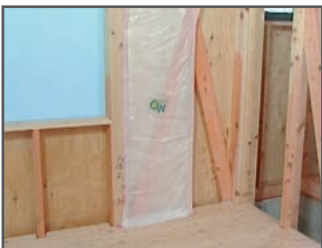
⑤ 防湿フィルムの下端は30mm以上出して床合板に留めつけます。
