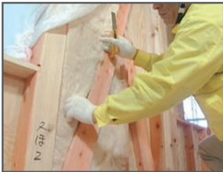
③ 筋交いのところでグラスウールに切り込みを入れ、押し込まれているグラスウールを筋交いと同面になるように盛り上げます。
