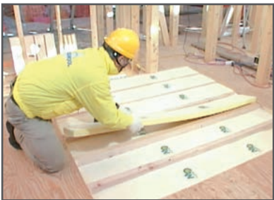
外気に接する床の施工例
