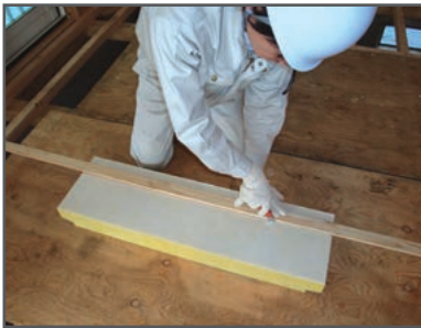
②根太間隔など寸法が合わない場合には、カッターであらかじめカットしてから施工してください。すき間が生じる場合には、グラスウールの端材を詰めます。
