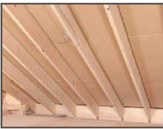
②通気層確保部材を施工する。
