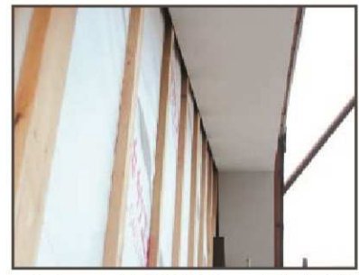
軒裏まで通気胴縁を通して通気を確保
