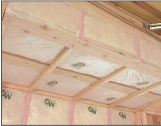
下屋の施工例（天井断熱の場合）
