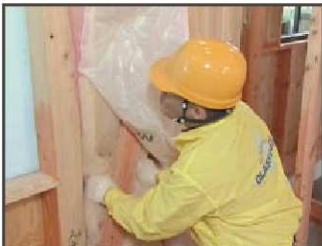
② 筋交いの後を通して裏側にグラスウールを充填します。
