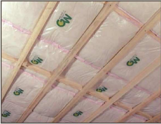
天井の施工例
