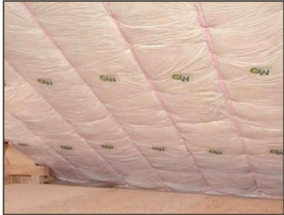
屋根の施工例
