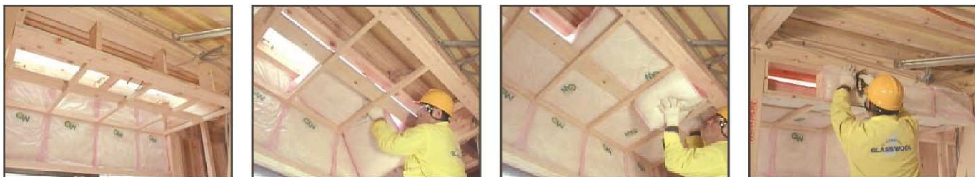
下屋の施工例（天井断熱の場合）
