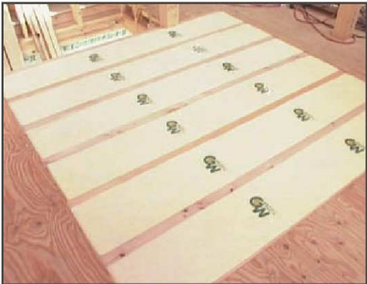
外気に接する床の施工例
