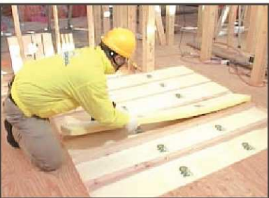
外気に接する床の施工例
