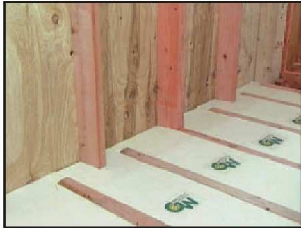
和室の床の施工例
