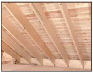
①施工前の状態。
