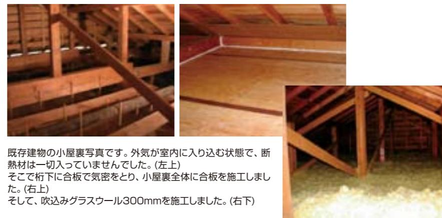
既存建物の小屋裏写真です。外気が室内に入り込む状態で、断熱材は一切入っていませんでした。(左上)
