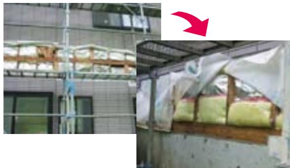
既存の外壁材を部分的に撤去して、土台上・胴差上下・桁下部分に**気流止め**(※)を施工しました。
