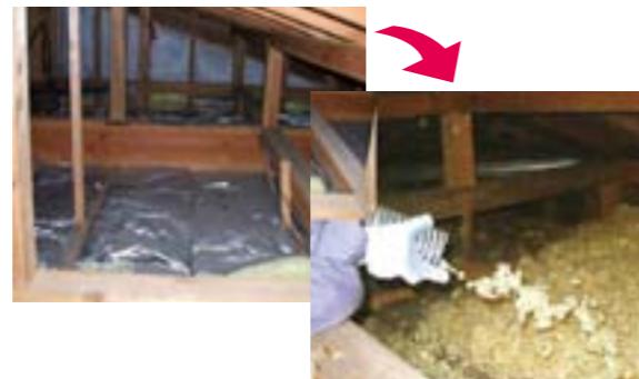
天井裏に、既存のグラスウール10K100mmに加えて、吹込みグラスウール300mmを施工しました。夏場の暑さ対策もこれでOK。
