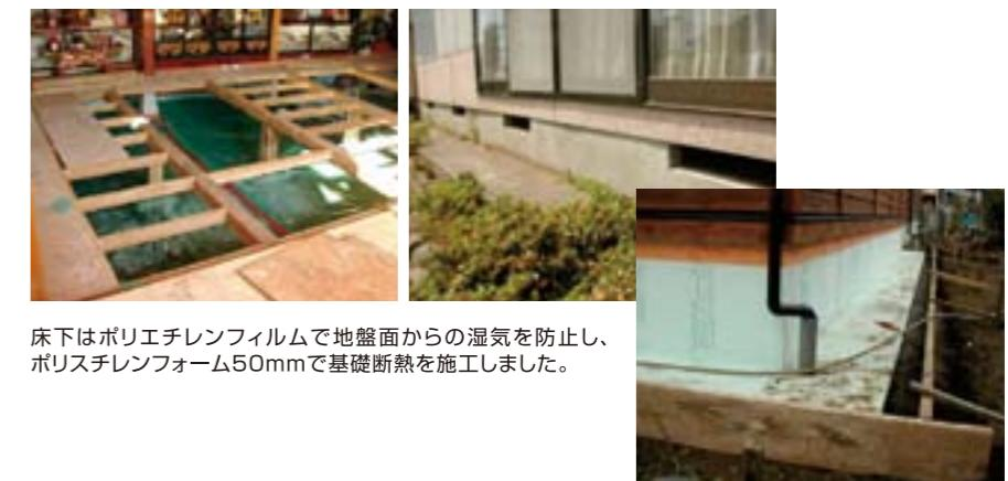
床下はポリエチレンフィルムで地盤面からの湿気を防止し、ポリスチレンフォーム50mmで基礎断熱を施工しました。
