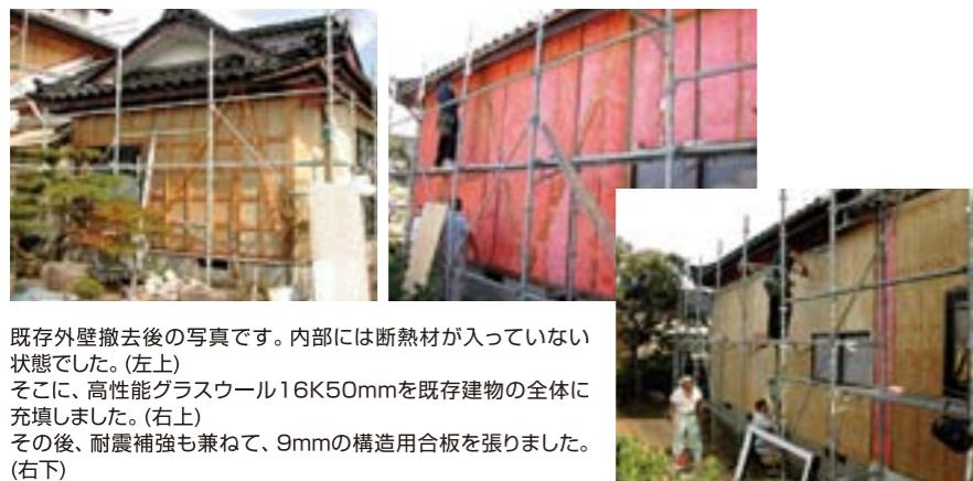
既存外壁撤去後の写真です。内部には断熱材が入っていない状態でした。(左上)
