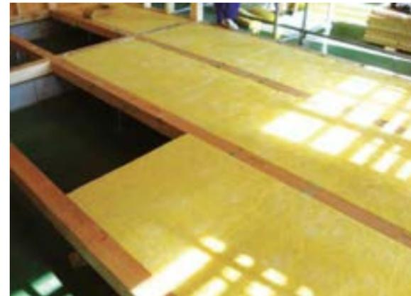
▼根太間の断熱材の施工
