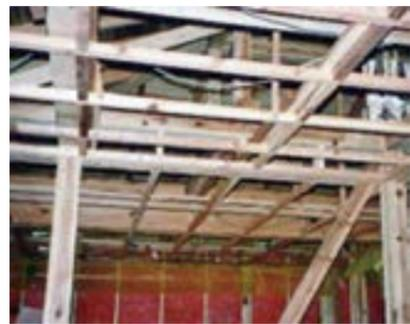
▼天井と間仕切り部分の防湿気密フィルム施工
