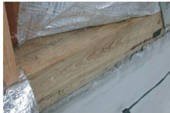
土台に腐食は見られず、良好な状態
