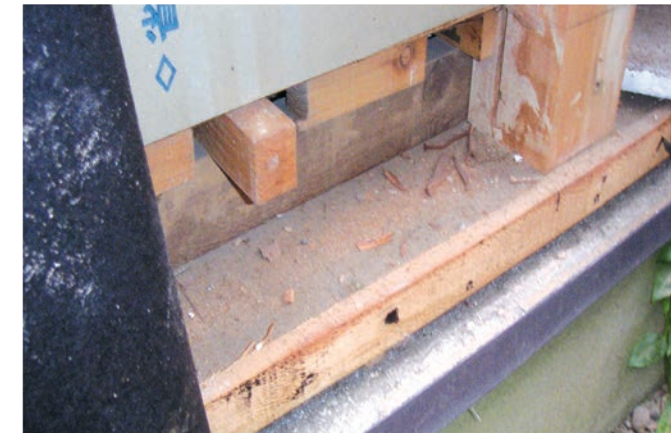
土台や柱の状態も良好で、腐朽等は見られなかった
