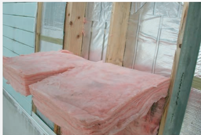
透湿防水シートを剥がしグラスウールの状態を見る ▶ 表面にわずかに黒いシミがあるが状態は良好
