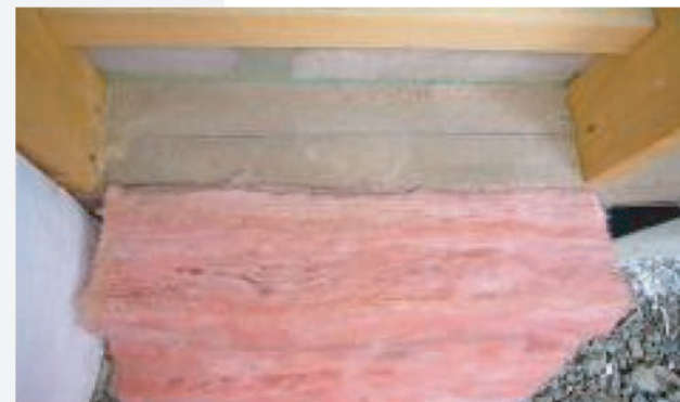
床下からの気流止めがきちんと施工されている ▶ グラスウールは施工時そのままの状態が保たれている
