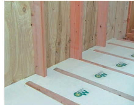
床と壁の取り合い部の施工例
