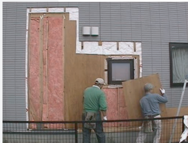
窓下の合板を剥がす ▶ サッシ周りからの漏水もなく良好な状態
