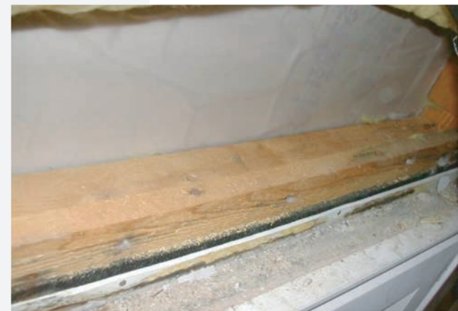
土台部分も乾燥している
