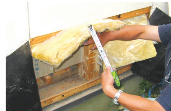
厚さを測定したところ50mm以上あり、竣工当時の厚さが確保されていた
