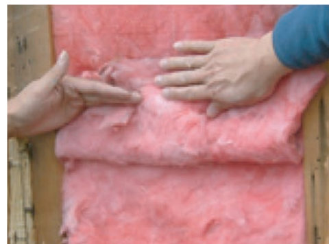
グラスウールには、蟻道もシロアリの被害も全く無し
