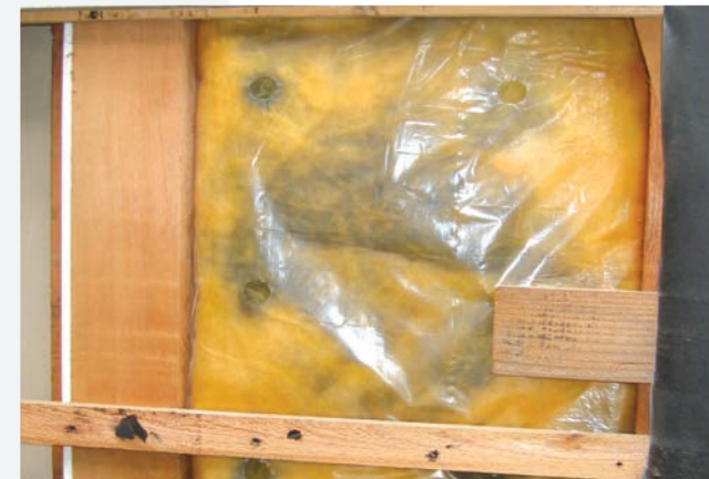
壁内を空気が流れたと思われる部分はグラスウールが埃で黒ずんでいたが、結露やカビは見られなかった
