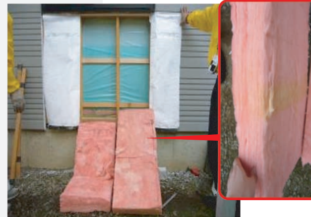
西側の壁を剥がし、防湿フィルムとグラスウールの状況を見る ▶ 結露も無く、グラスウールの状態は良好
