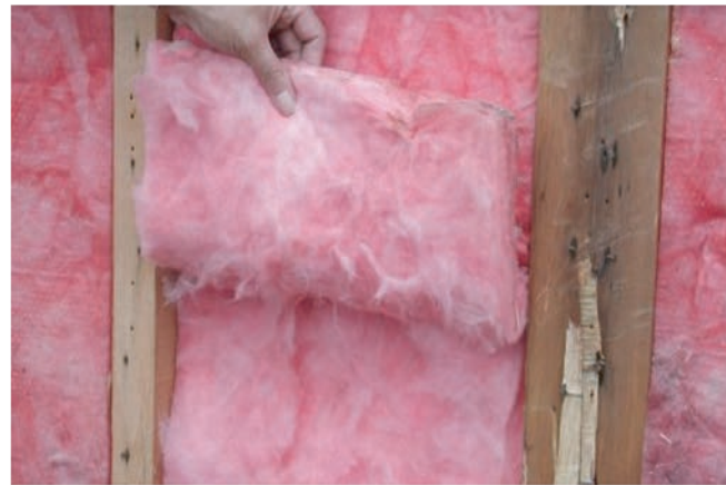
グラスウールも施工時と変わらず、弾力も充分
