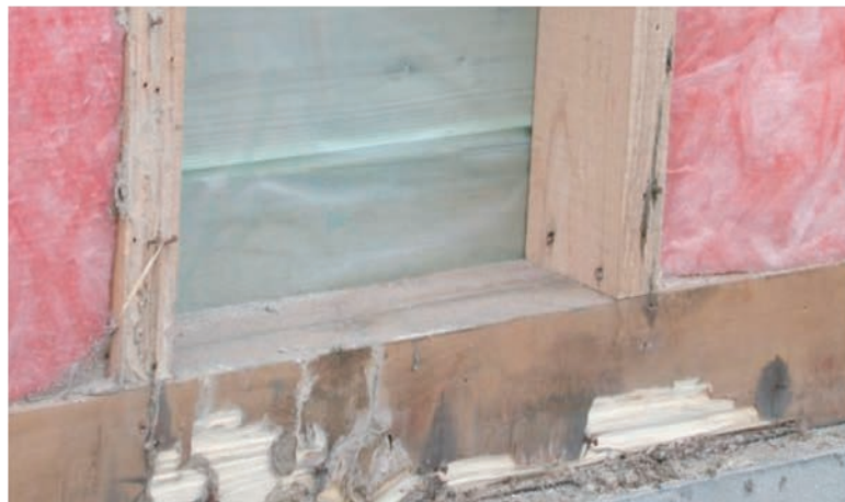
土台も美しい状態で、断熱施工に問題は見られなかった
