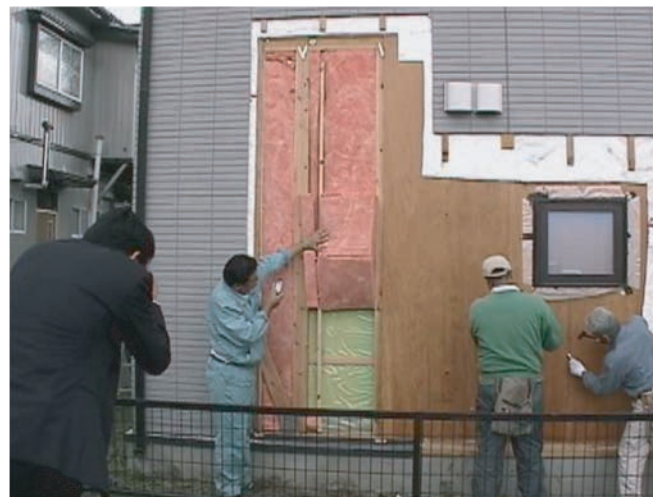
グラスウールをめくり防湿フィルム側を確認 ▶ 結露の形跡もなく良好な状態
