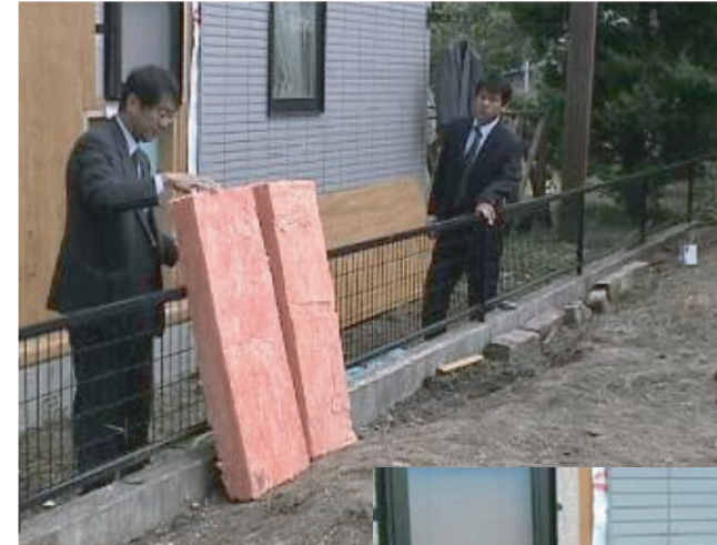
取り出したグラスウールをフェンスに立てかけて剛性をチェック ▶ 新品同様の剛性で、全く劣化なし
