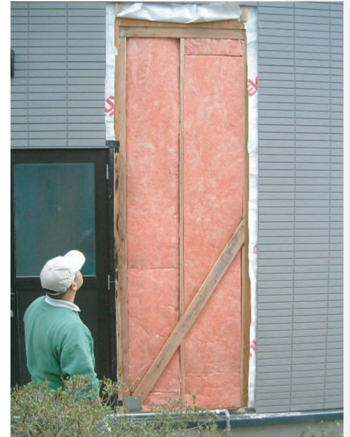
北側の壁内の状態を検証 ▶ カビが生えた様子はなく、全く結露していないことが伺える
