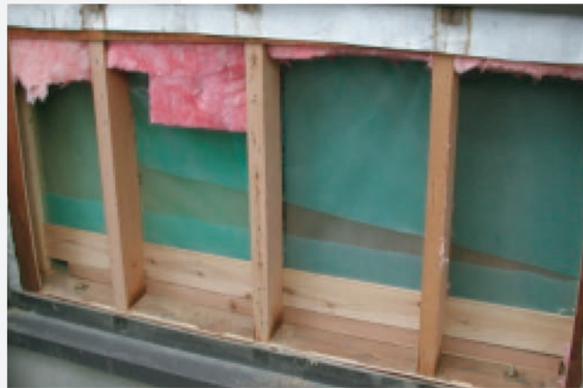
最も結露しやすいと思われていた西側の壁を剥がす ▶ 結露の痕跡は全く見られない
